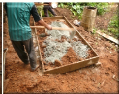
นำปูนซีเมนต์มาผสมกับดินที่เตรียมแล้วคลุกเคล้าในอัตราส่วน ๑ : ๗
