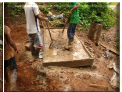
นำดินจากการขุดแต่งตัวฝายมาผสมน้ำและคลุกเคล้าดินกับปูนซีเมนต์
