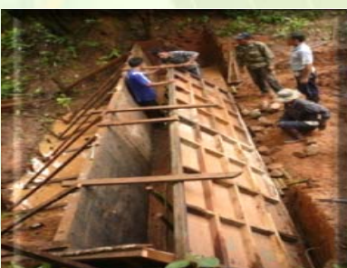
การเทคอนกรีตแบบ Soil Cement ช่วงร่องแกนฝายใส่หินใหญ่ลงไปเพื่อเสริมความแกร่งโดยใช้ไม้ไผ่เป็นตัวเสริมรับแรง
