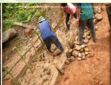
การตั้งแบบเพื่อเตรียมเทคอนกรีต Soil Cement โดยใช้ไม้ไผ่ผูกขึ้นมาที่ละชั้น ชั้นละ ๒๐ ซม.ของการวางเรียงหินใหญ่
