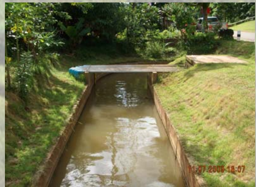
ระบบส่งน้ำ (รางส่งน้ำคอนกรีตเสริมเหล็ก)
