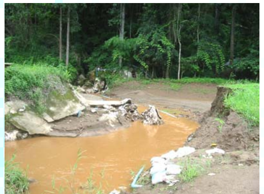
คันดินสระเก็บน้ำถูกกระแสน้ำจากถ้ำน้ำสุรายทางกัดเซาะขาด (5 ก.ค. 49)
