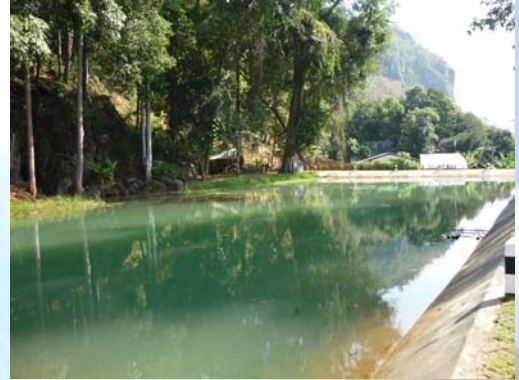
สระเก็บน้ำดาดคอนกรีต
