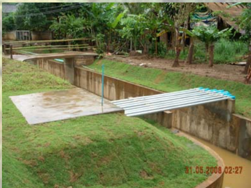
อาคารท่อส่งน้ำและอาคารจ่ายน้ำ
