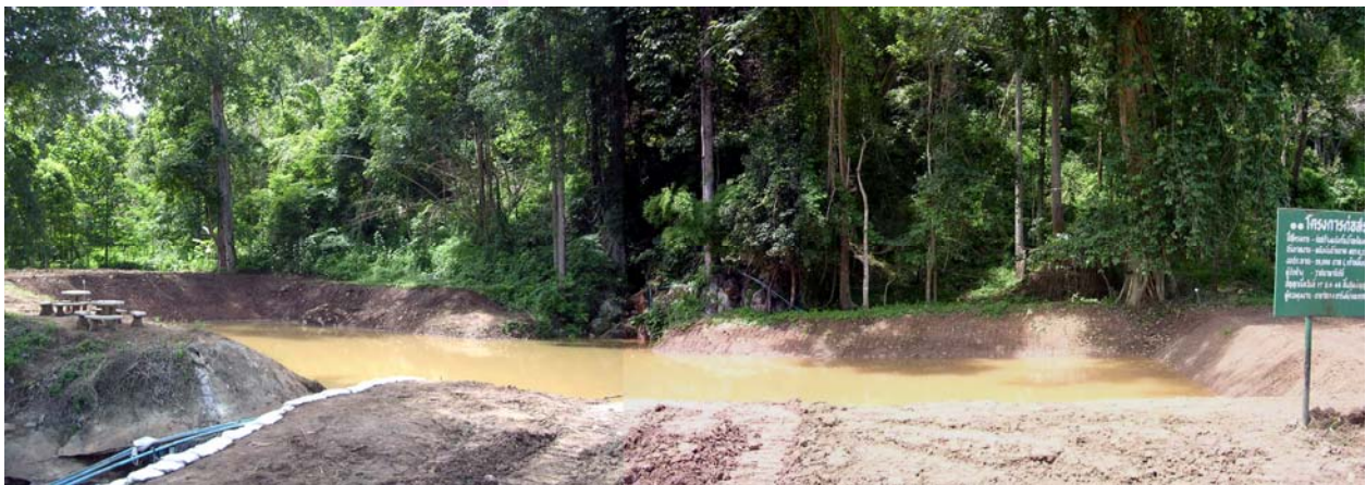
ทำนบดินโอบรอบปากถ้ำน้ำสุรายทาง เพื่อเก็บกักน้ำสำหรับการเกษตรและการอุปโภค (ก่อนดำเนินโครงการฯ)
